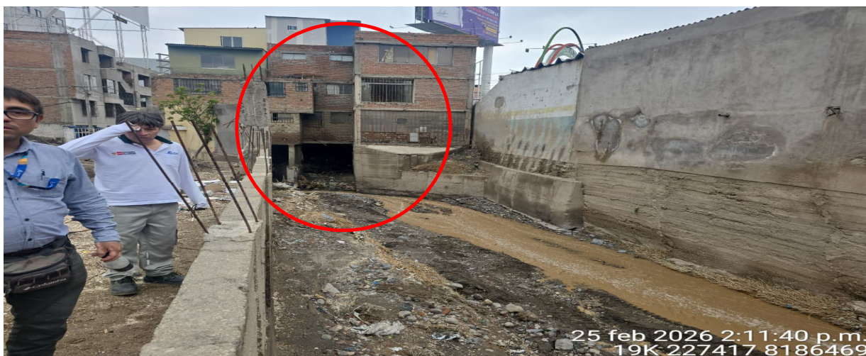
IMAGEN 01: SE OBSERVA LA QUEBRADA COLMATADA A LA ALTURA DEL PUENTE JUAN PABLO QUE ATRAVIESA EL AGUA POR DEBAJO DE UNA VIVIENDA
