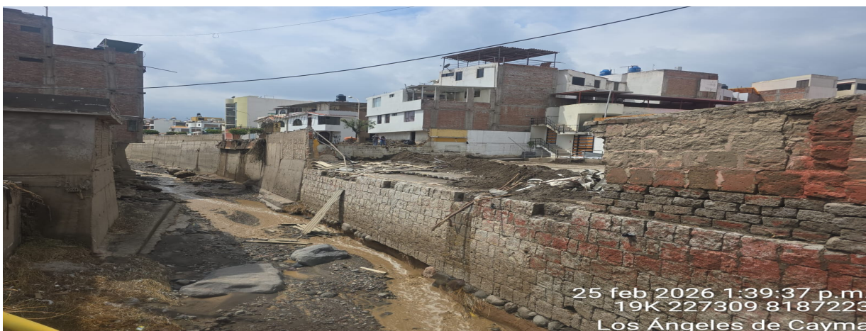
IMAGEN 02: SE OBSERVA LA COLMMATACION Y LA EROSION EN LA MARGEN DERECHA DE LA QUEBRADA CHULLO QUE REQUIERE DP ROTECCION CON
